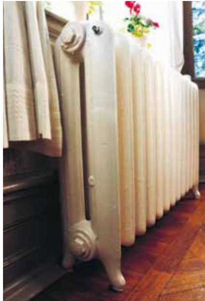
När Bergslagsbanans stationshus i Göteborg byggdes om fick snickaren Henrik Benjegård några av husets gamla radiatorer. De passade bra i Villa Sjötorp, som fick vattenburen värme i samma veva.
